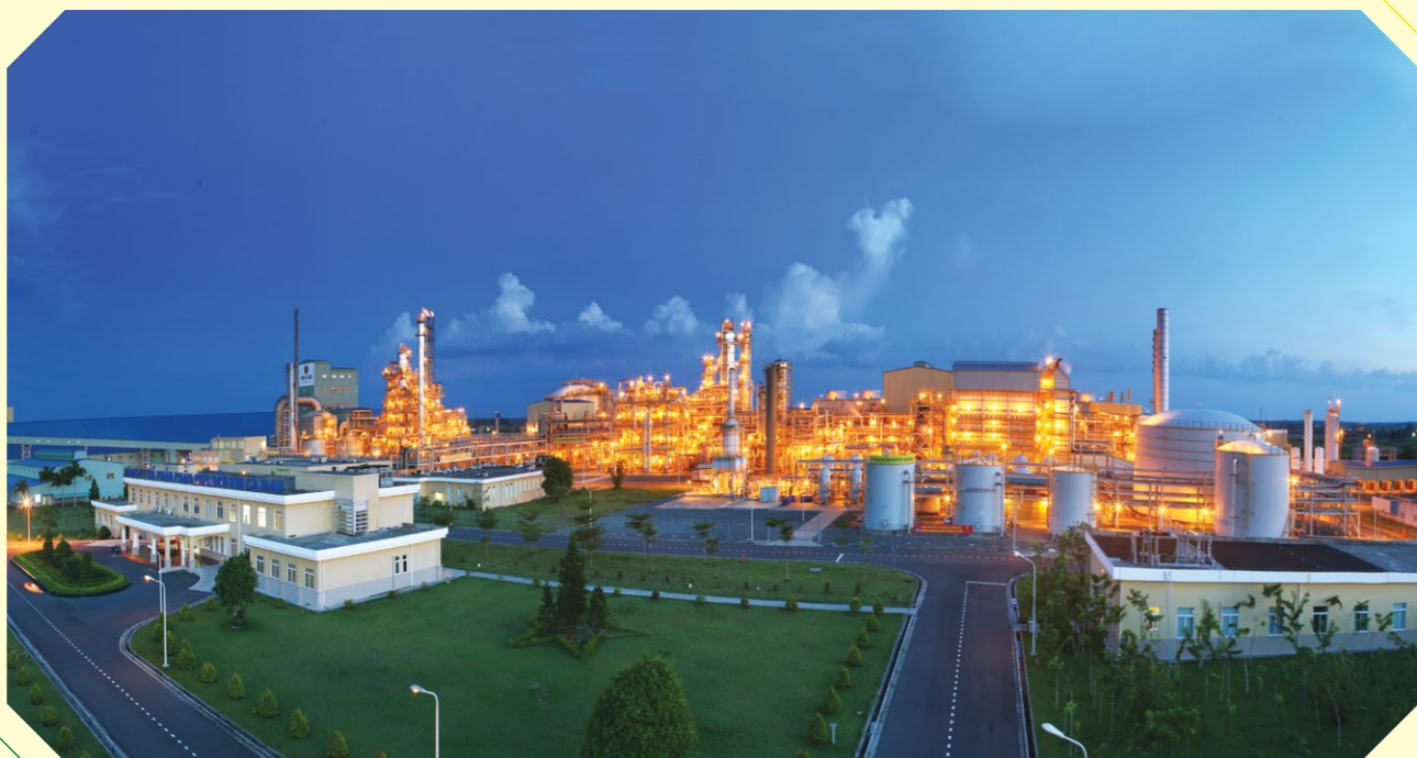
Tổng thể Nhà máy Đạm Cà Mau trong cụm Khí - Điện - Đạm Cà Mau
