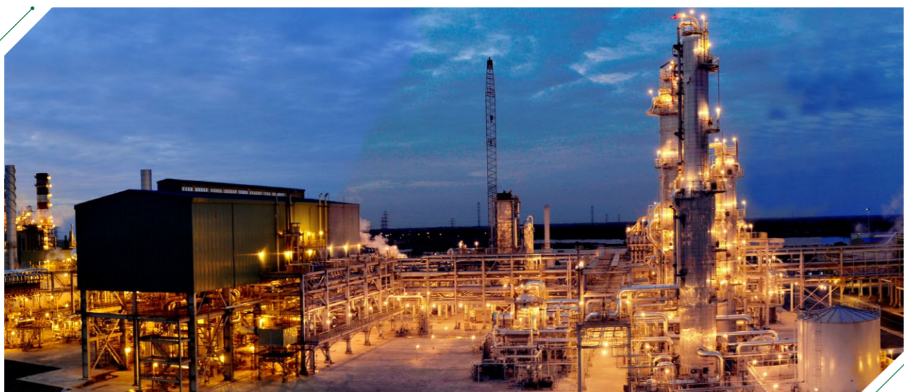
Hình chụp tại Nhà máy Đạm Cà Mau
