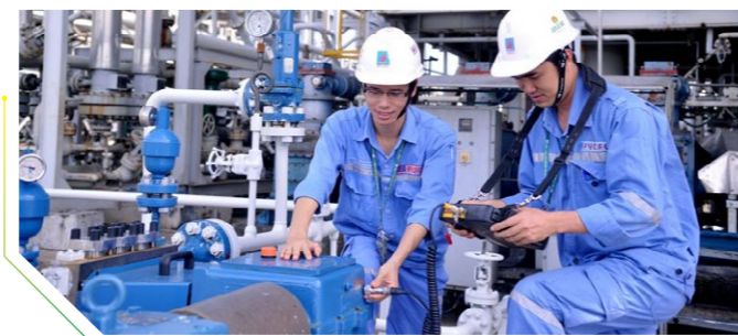
Đội ngũ kỹ sư của PVCFC hoàn thành bảo dưỡng tổng thể nhà máy trước kế hoạch đặt ra mà không huy động chuyên gia nước ngoài
